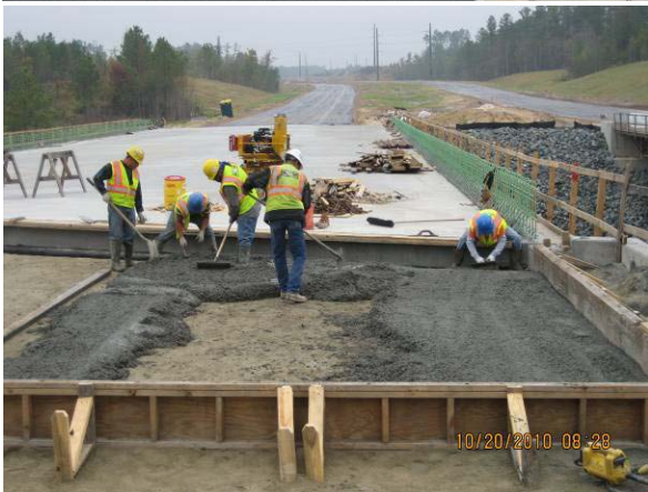
Picture 1: Site #14 US 64 – Pour End Bent #2 NB cap and backwall. Picture 3: Site #23 Panther Creek – Pour seal slab at End Bent #1 SB
