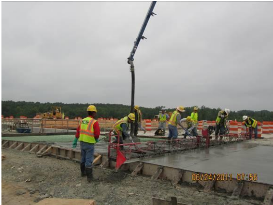
Site #6 US1 - Pouring Approach Slab EB1 NB
