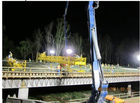
Site #11 Beaver Creek – Deck Pour C & D
