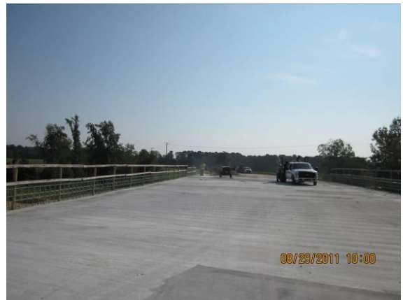
Site 16 Jenks Rd Deck
